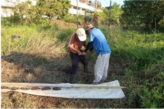
圖版 183：A9 人工鑽探工作照
