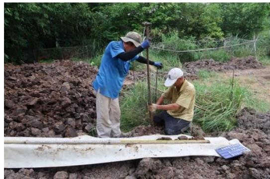
圖版 156：A2 人工鑽探工作照
