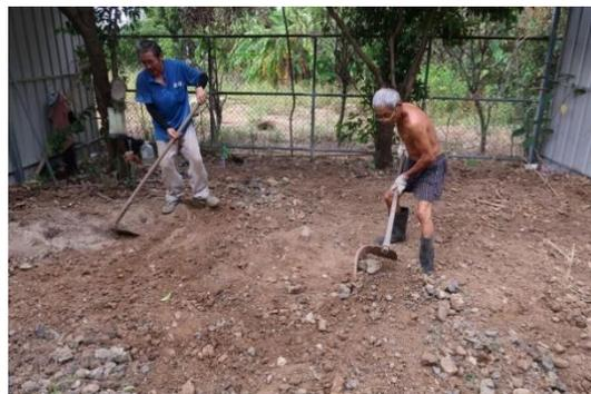
圖版 149：TP6 人工回填工作照
