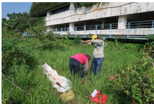
圖版 33：P1 人工鑽探工作照
